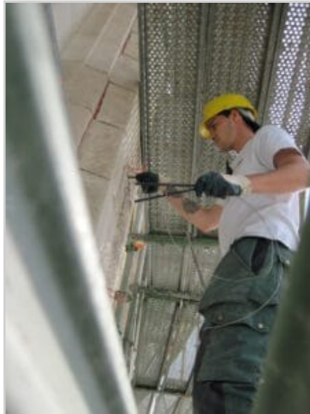
Aanbrengen Titanium-anodes
