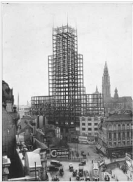
KBC toren in aanbouw
