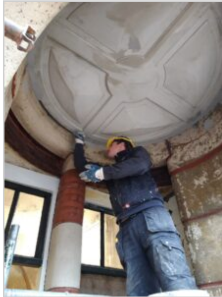
Het afwerken van het nieuwe ornament
