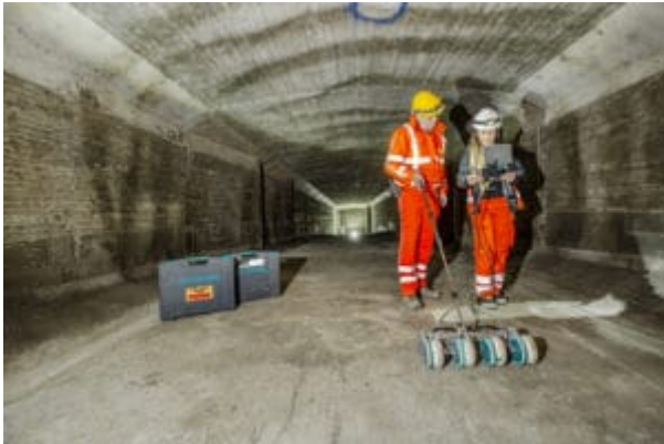
Vaststellen van wapeningscorrosie door potentiaalmetingen
