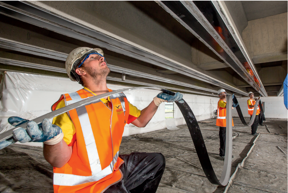
4 Verlijmen van koolstofvezel lamellen aan de I-liggers
