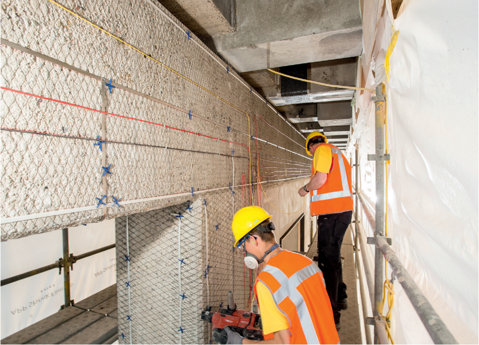
3 Applicatie van kathodische bescherming ter behoud van de steunpunten
