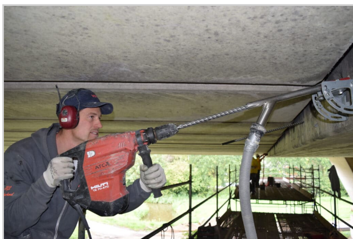
Boorwerkzaamheden t.p.v. de voorgespannen tandoplegging (A9 – Amstelveen)
