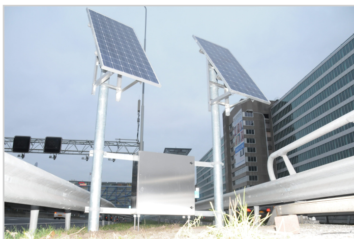
Stroomvoorziening m.b.v. zonnepanelen en accu's
