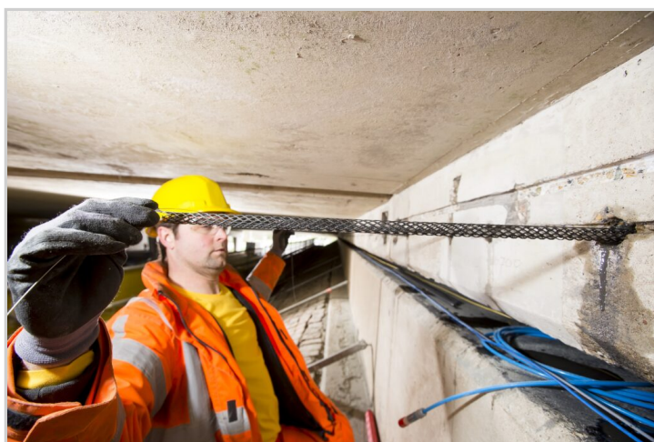
Het plaatsen van de titanium anodes in de voorgespannen dwarsdrager (A6 – Naarden)
